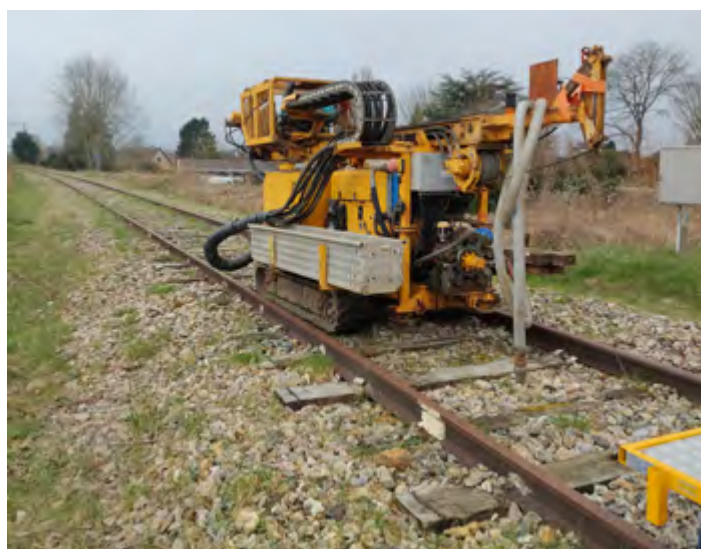
Travaux sur ligne ferroviaire
