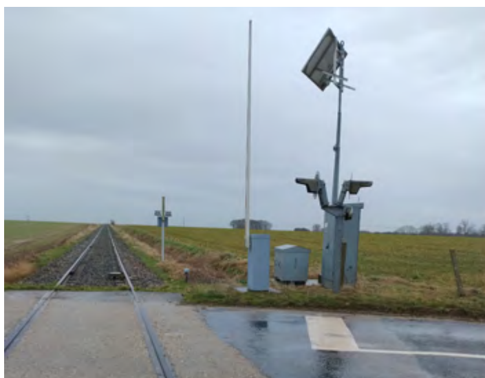
Passage à niveau à alimentation solaire
