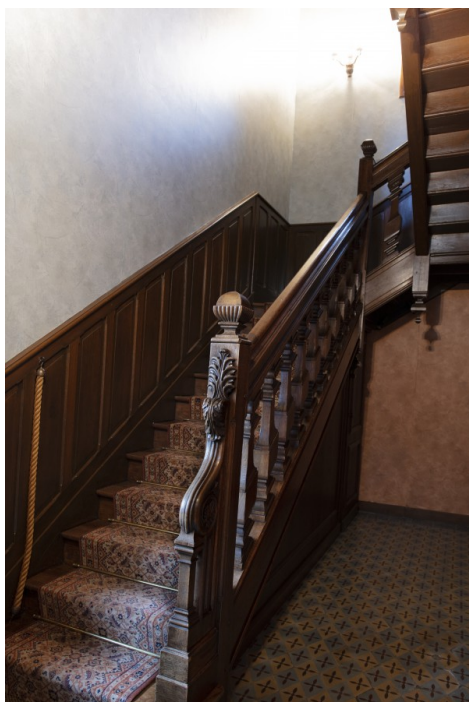
Vue générale de l'escalier à balustres de style 17e siècle et sol en carreaux de ciment © Département de la Seine-Maritime
