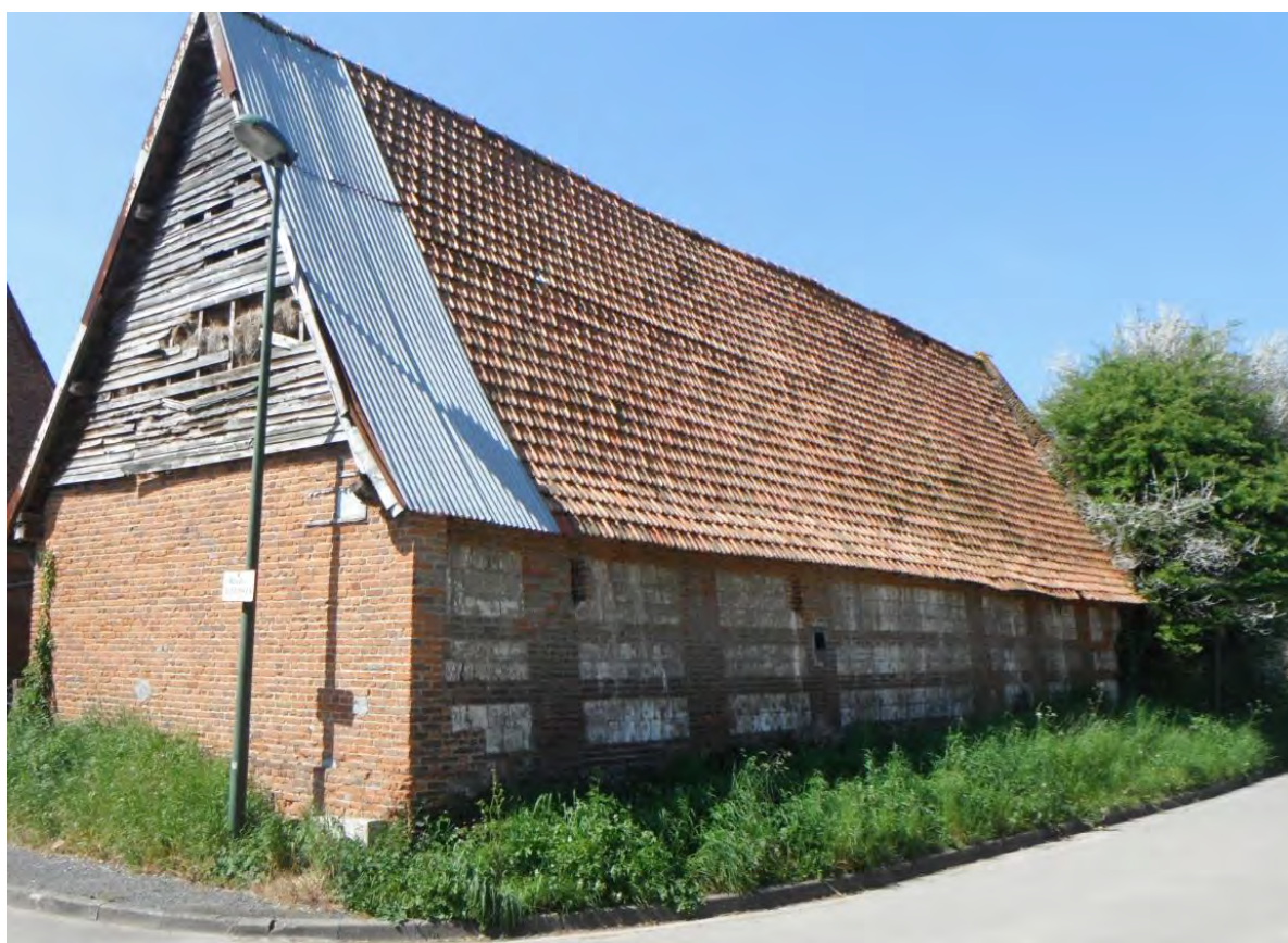
Bâtiment avec appareillage en moellons crayeux – Limite Rouxmesnil-Bouteilles/Saint-Aubin-sur-Scie
