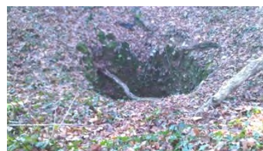
Exploitation souterraine avec entrée par puits
