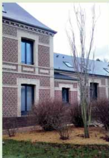
Côté rue du Vallon
