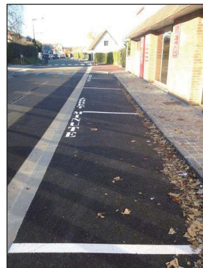
Après les travaux
